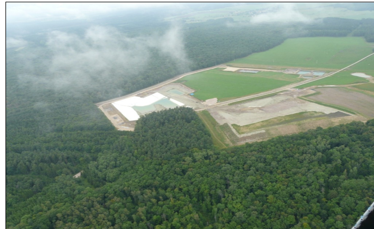
Décharge de Villoncourt – Arrivées d'eaux bleues continues dans toutes les excavations
