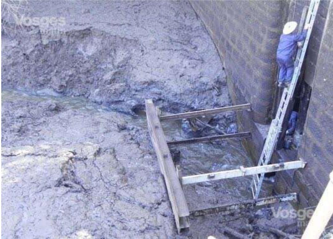
L'eau est tout naturellement passée à côté du barrage et le bassin s'est complètement vidé au détriment de la rivière en aval.
