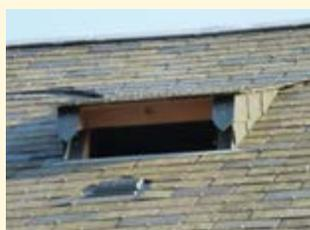
▲ Une «chiroptière» (ouverture de 16x40 cm) pourra être mise en place pour l'accès en vol des chauves-souris.
